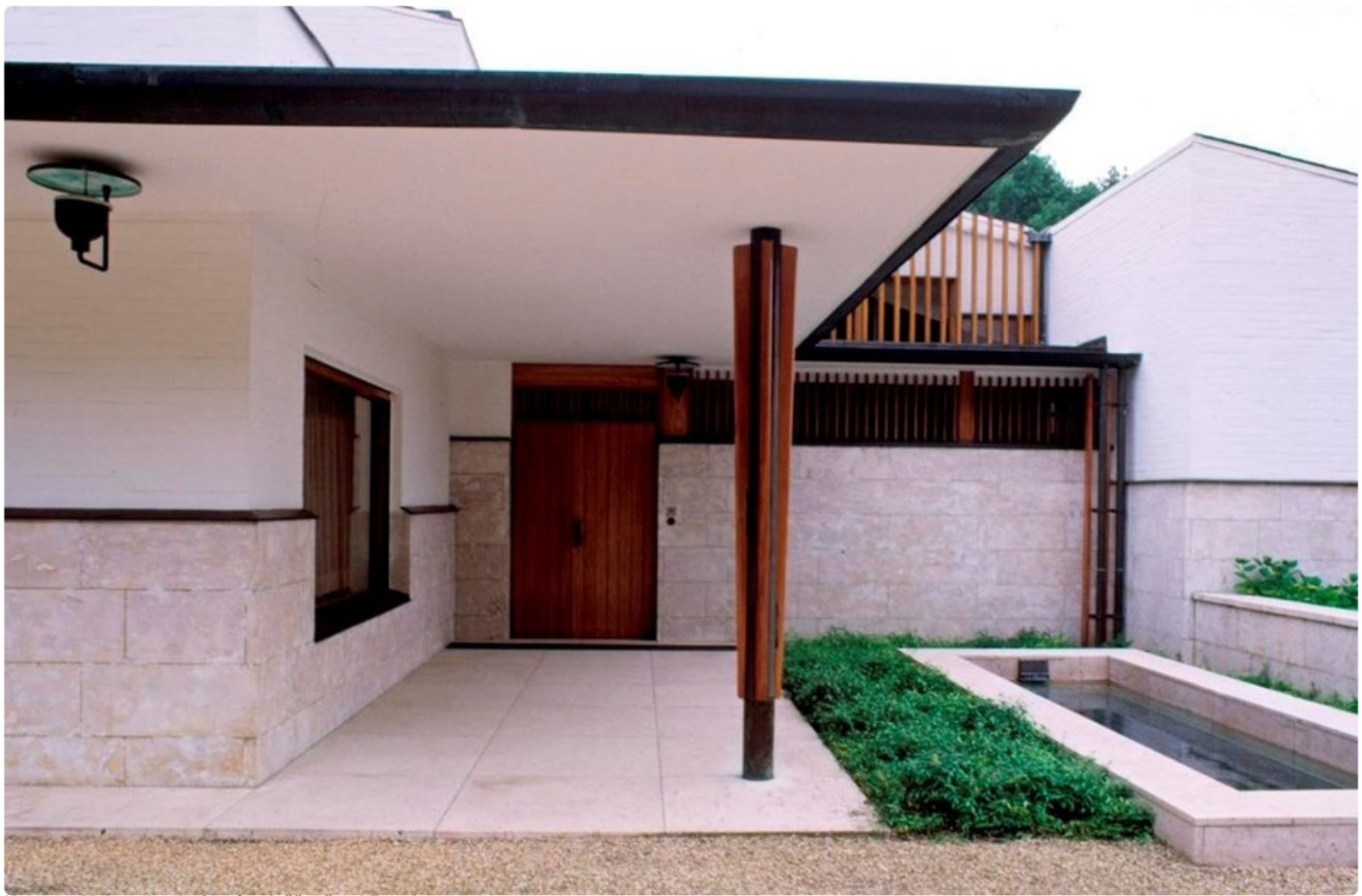
Kuvassa Maison Louis Carrén sisäänkäynti Ranskassa. Valokuva Martti Kapanen © Alvar Aalto -säätiö.
