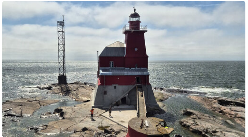
Kallbådanin majakka toimii nykyisin valaisemattomana tunnusmajakka. Majakkavallo siirrettiin vuonna 2015 tornista 10 metrin päähän valotolppaan. Kuva: Väylävirasto
