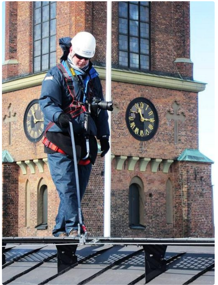
Turvaljaan hihnaa kuljetetaan kuin ulkoiluttaisi koiraa, mutta sen liikuttaminen vaatii hieman harjoittelua.
