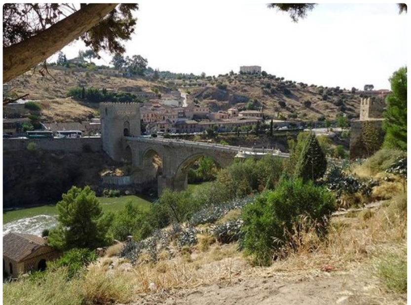
Tajo-joen ylittävä historiallinen silta palvelee nykyisin jalankulkuliikennettä.
