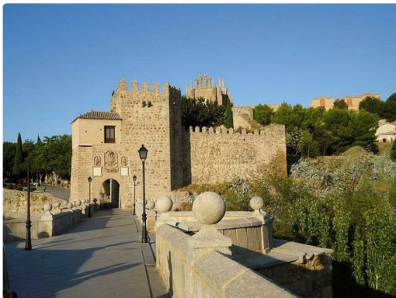
Kaupunkikuvaa leimaavat muurit, sillat, luostarit ja kirkot.
